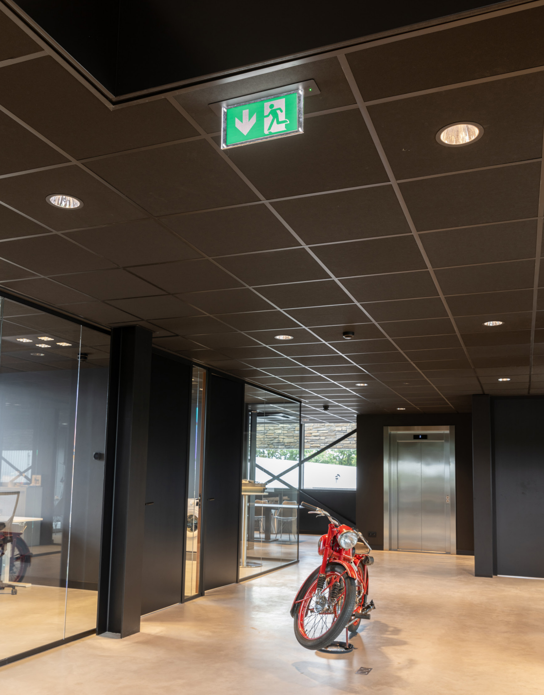
Downlights (136-454), led-panelen (173-063) en noodverlichting (600-018 en 600-032) in kantoorpand Strijbosch - Nistelrode
