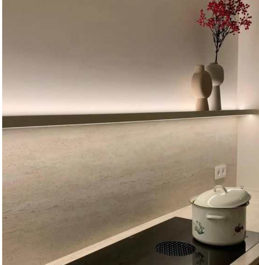
Voor functionele verlichting, onder keukenkasten om een keukenaanrecht te verlichten, wordt 1.000 lm/m tot 1.500 lm/m aangeraden (Govaerts Elektro)
